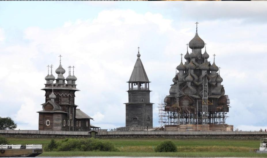
Для реставрации разработана не имеющая аналогов технология: поэтапная переборка сруба при помощи лифтинга.
